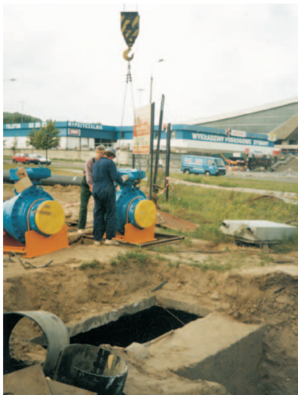
Установка шарового крана «Баллостар» KHSVI в Польше
