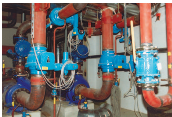
Шаровой кран KHI в теплосети
