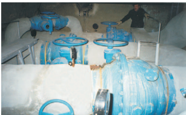
Шаровые краны «Баллостар» Ду 600, г. Москва, установка в шахте, горячая вода 135°C 12 бар
