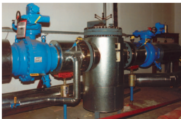
Шаровой кран KHI в теплосети
