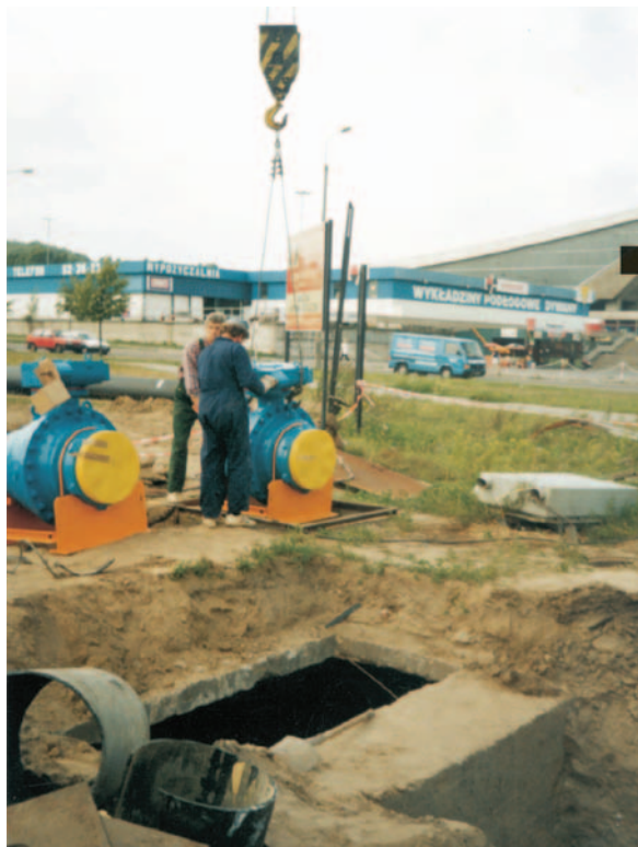
Установка шарового крана «Баллостар» KHSVI в Польше
