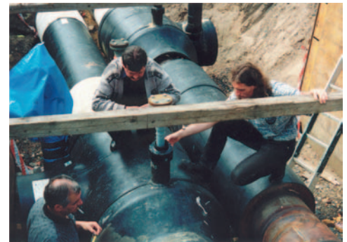
Предизолированный шаровой кран «Баллостар»: до, во время и после установки на трубопроводе.
